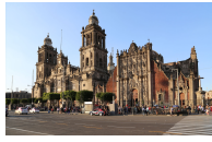
Vista general del conjunto, 2016.
