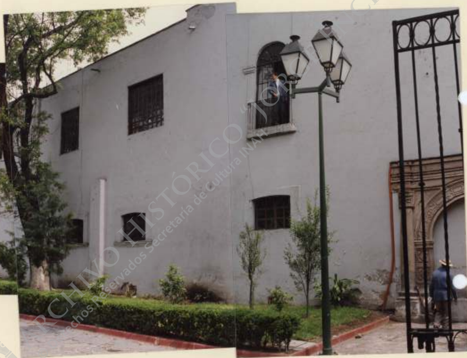
FACHADA NORTE VISTA ATRIO
