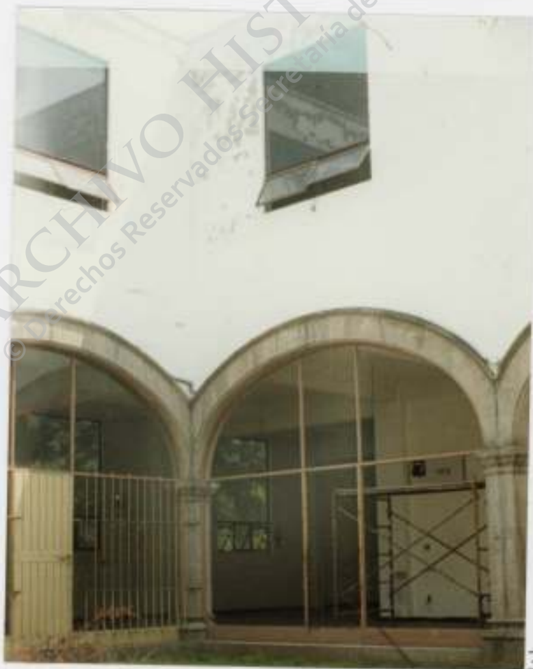
ARCADA PATIO INTERIOR.
