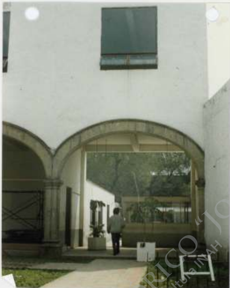
ARCADA PATIO INTERIOR.
