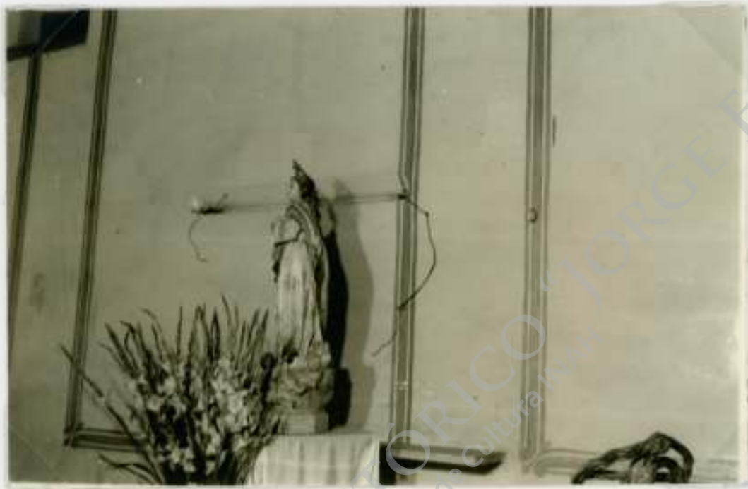
FOTO 20 SUSTITUCION DE AZULEJO, APLANADO Y PINTURA DE LAS PAREDES DE LA CAPILLA (24-V-73)
