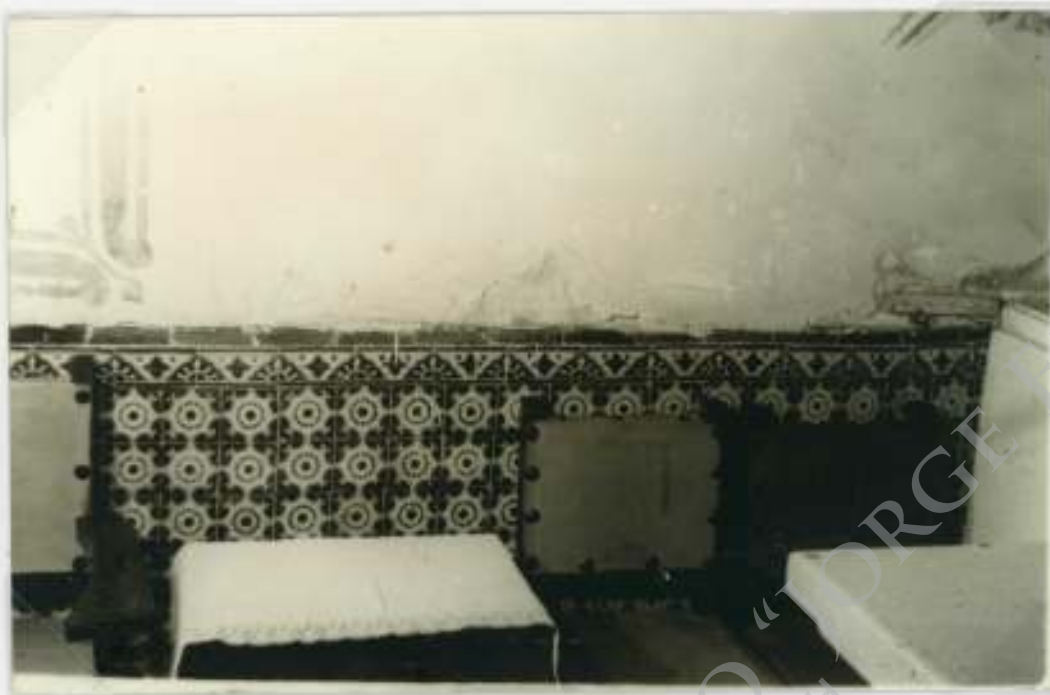
FOTO 5 PAREDES LATERALES DEL PRESBITERIO (24-V-73)
